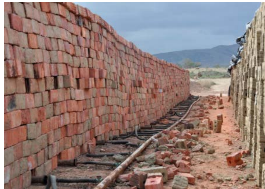
Республика Дагестан, несанкционированное подключение и использование несертифицированного оборудования при производстве кирпича
