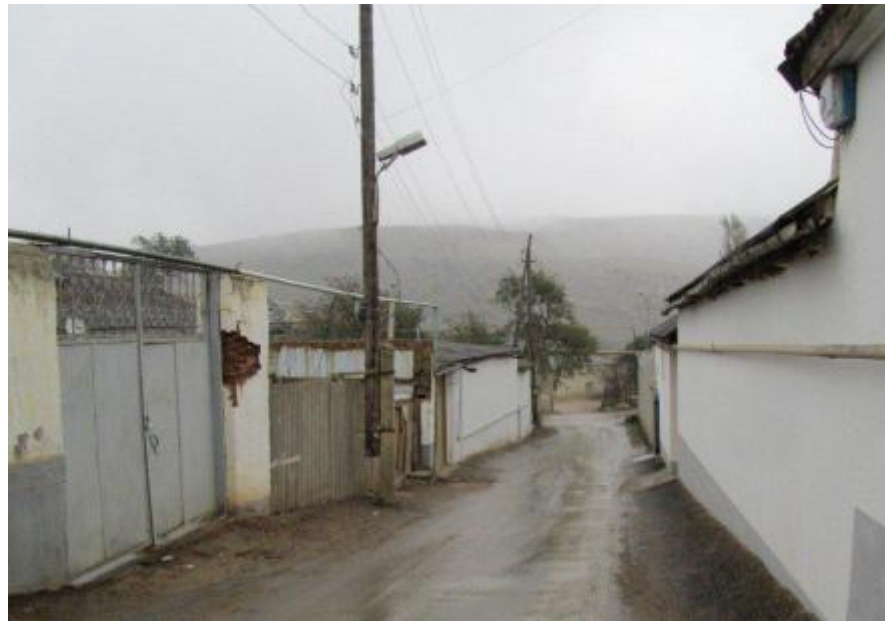
Республика Дагестан, Карабудахкентский район, отсутствие табличек с адресами и номерами домов
